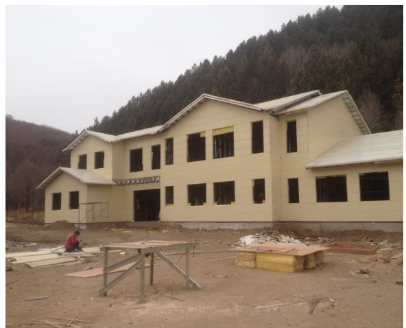
管理主体基本完工
