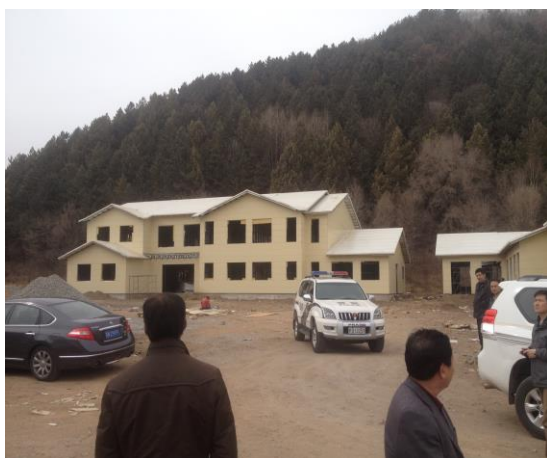
建设中的管理站
